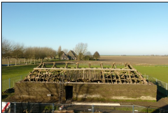
Aanblik op het zodenhuis vlak voor de winterstop. De kapconstructie is al voor een groot deel opgebouwd en steunt volledig op de zodenmuur. Foto: GLA
