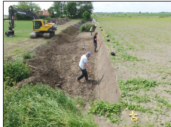
Foto 1: De net blootgelegde de steilkant te Dronrijp-Zuid, gezien vanuit het oosten. Rechts het intacte en links het afgegraven terpdeel. Foto: J. van Gent
