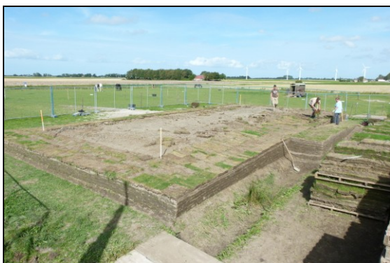
Het huispodium, met langsij een hellingbaan. De jalons geven de buitenste hoekpunten van het zodenhuis aan.
