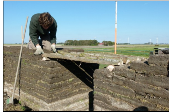
Gijs Nieuwlaat plaatst de balken die de deur in het stalgedeelte overspannen.
