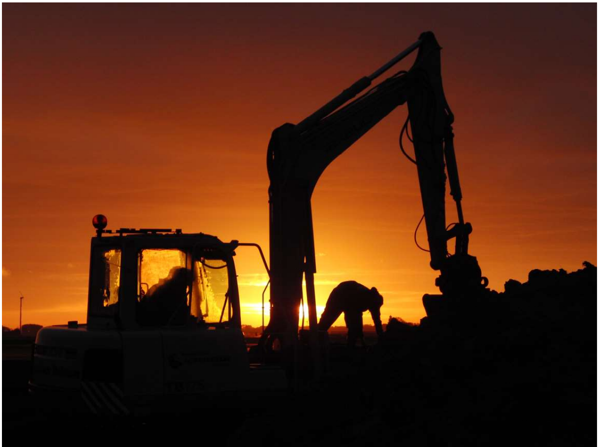
Dronrijp-Oost, 16 oktober 2012, 08:13. Zonsopkomst tijdens het verwijderen van de eerste laag klei.
