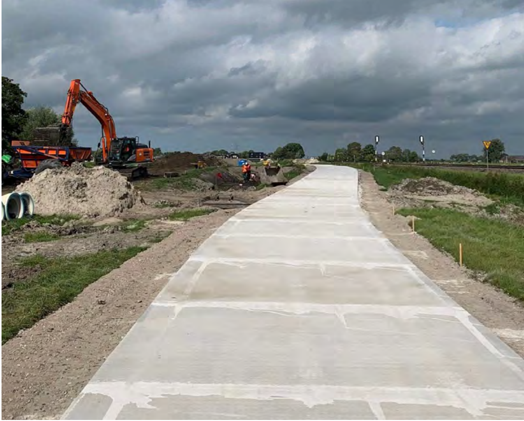
Het net gelegde fietspad met links daarvan de opgraving op de plek van de nieuwe sloot. Foto Michiel Rooke.
