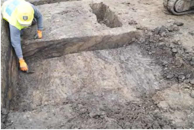
4. De trapconstructie wordt blootgelegd. In het profiel zijn de bruine bovenzijden van de zoden zichtbaar waar het gras op heeft gegroeid. Links (zwart en donkergrijs) de afvallagen, rechts (grijs) het ophogingsmateriaal.
