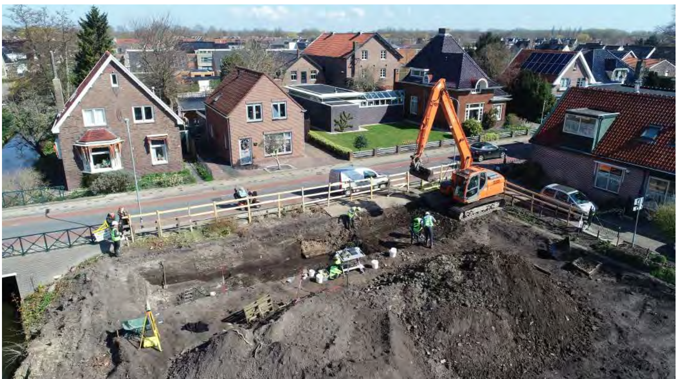
5. Droneopname tijdens de aanleg van de sleuf aan straatzijde.
